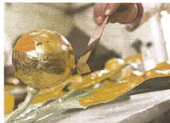
Auf dem Dach der Wiener Secession: Das Skelett der Kuppel wurde bereits restauriert und wird derzeit neu montiert. In einer Werkstatt in Wien-Floridsdorf werden derzeit sämtliche 2500 Lorbeerblätter in Handarbeit möglichst originalgetreu neu vergoldet. Das „Krauthappel“ war bereits stark verwittert.
