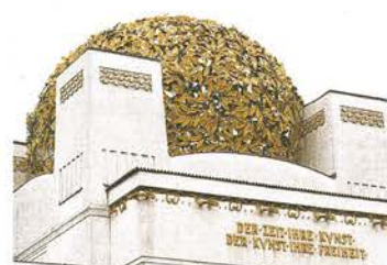
Auf dem Dach der Wiener Secession: Das Skelett der Kuppel wurde bereits restauriert und wird derzeit neu montiert. In einer Werkstatt in Wien-Floridsdorf werden derzeit sämtliche 2500 Lorbeerblätter in Handarbeit möglichst originalgetreu neu vergoldet. Das „Krauthappel“ war bereits stark verwittert.
